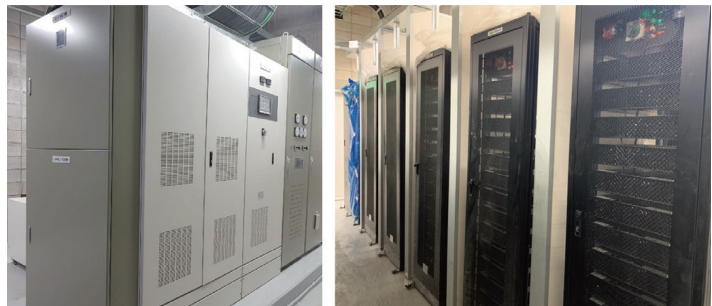
서진학교 하이브리드 ESS 250KW 시스템
